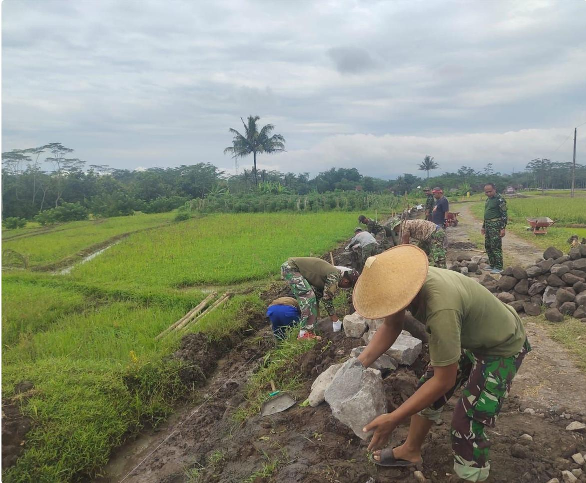
Bentuk program pembangunan Pra TMMD Kodim Magelang dengan pengerjaan rabat beton jalan dengan panjang 410 meter, lebar 4,2 meter ketebalan 0,12 meter dan pembuatan senderan jalan. Kegiatan pengerjaan tersebut diawali dengan pra TMMD, sehingga dengan demikian pembangunan lebih cepat di nikmati oleh masyarakat. Program pembangunan yang ada di dua sasaran tepatnya di Dusun Bojong dan Dusun Joho Desa Pancuranmas Kecamatan Secang Kabupaten Magelang
