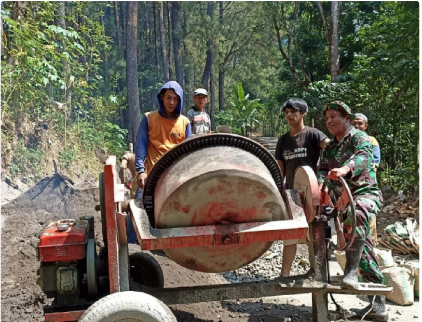
Satgas TMMD kebut pengecoran jalan
