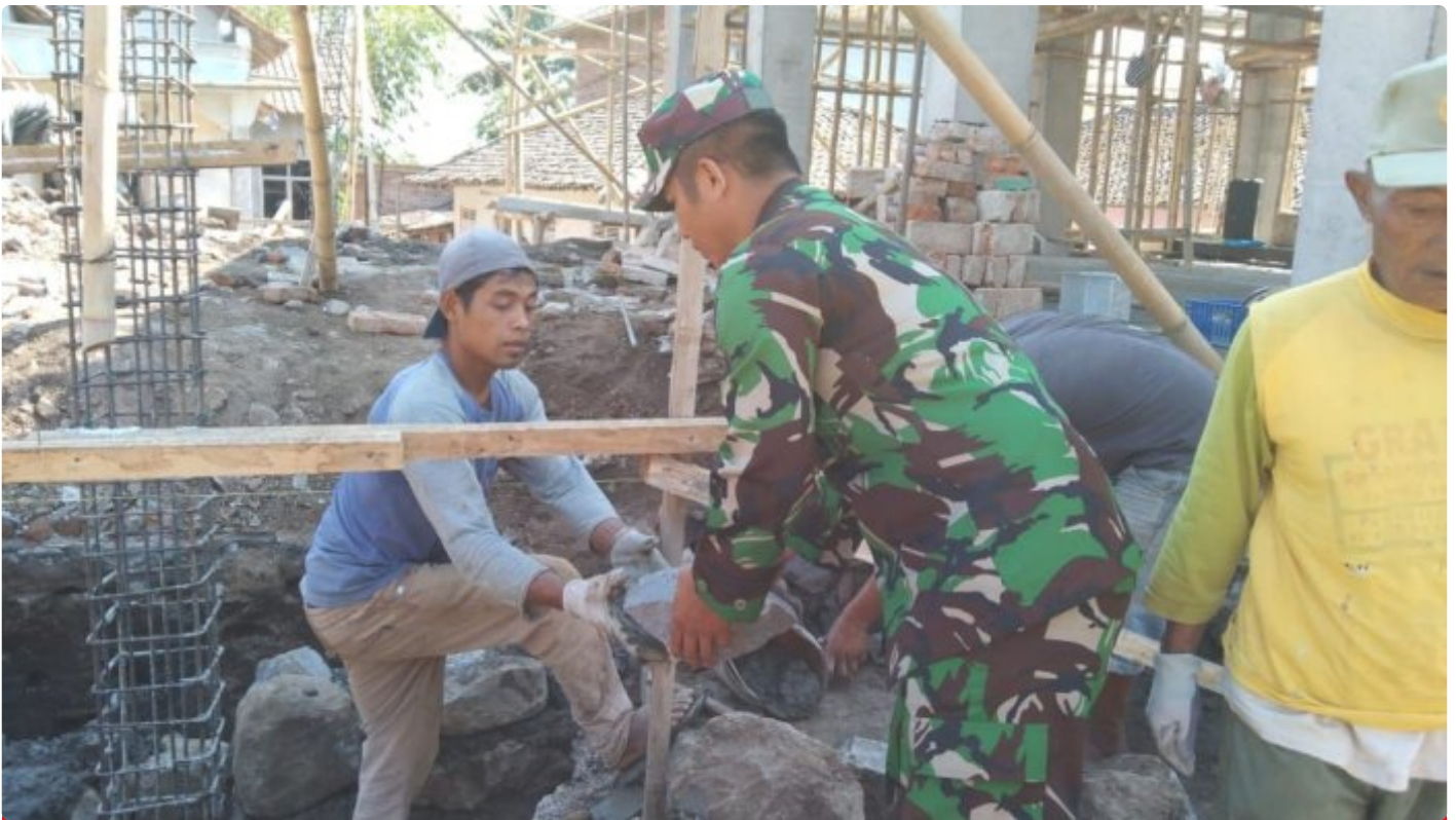
Serda Nasikin bantu pemasangan batu pondasi masjid
